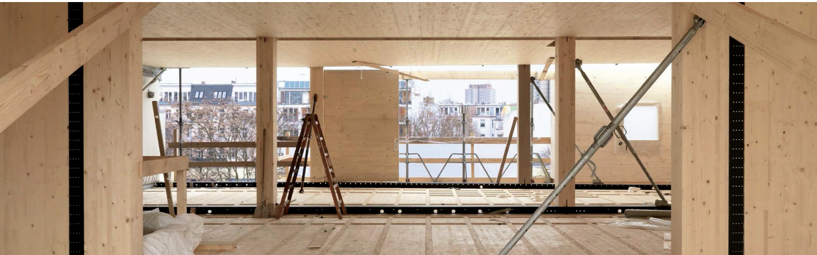
Geschosswohnungsbau Berlin (Arch. Kaden + Partner)
